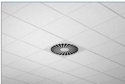
Montaż w sufitach z teownikami
