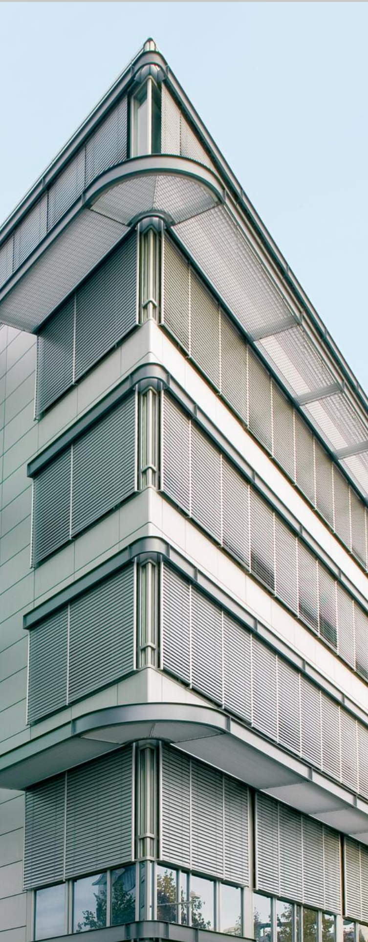
Zastosowanie w budynku biurowym Regulatory zmiennego przepływu TVZ i TVA z elementami sterującymi do integracji z systemem zarządzania budynkiem
