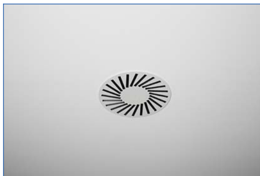
Montaż w sufitach pełnych
