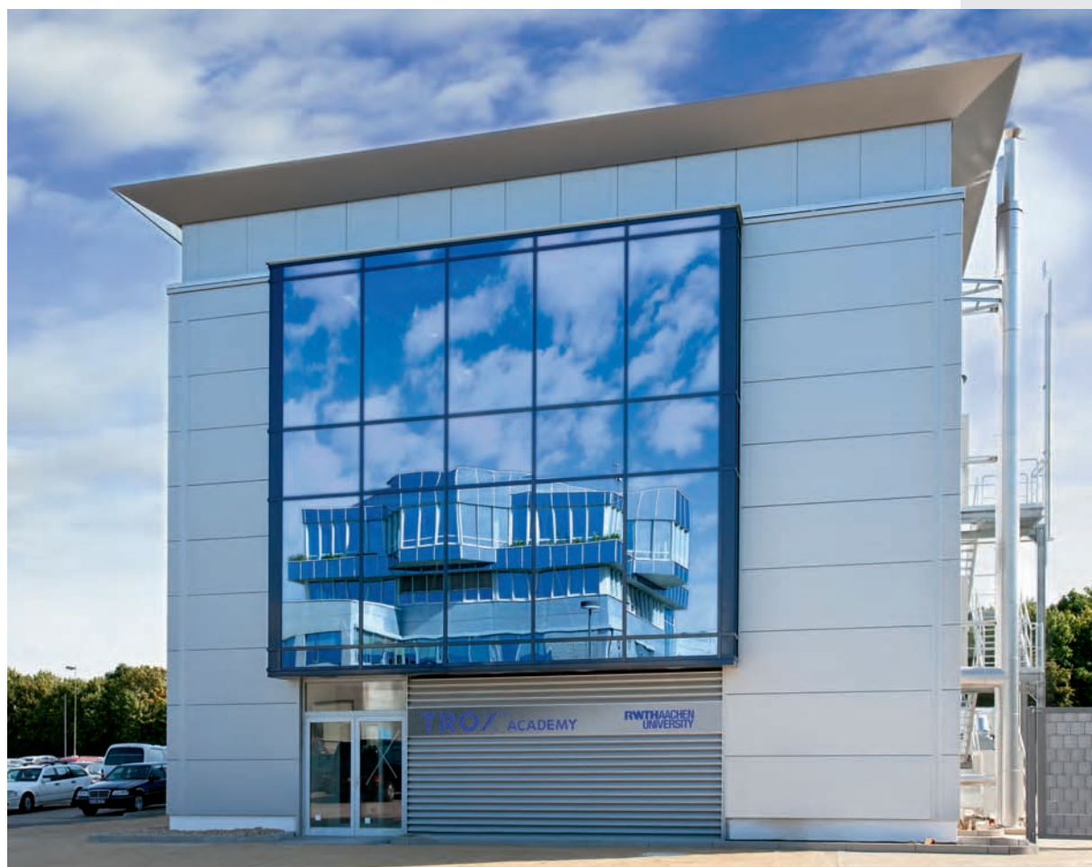
Międzynarodowe Centrum Ochrony Przeciwożarowej (ICB) w Neukirchen-Vluyn, Niemcy, otwarte w 2009.
